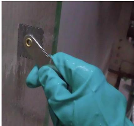
2、剥離剤が適量塗布できているかどうかを、ウェットフィルムゲージにて確認する。
