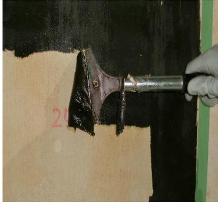
4、塗膜軟化を確認後、スクレーパーにより旧塗膜を剥離させる。
